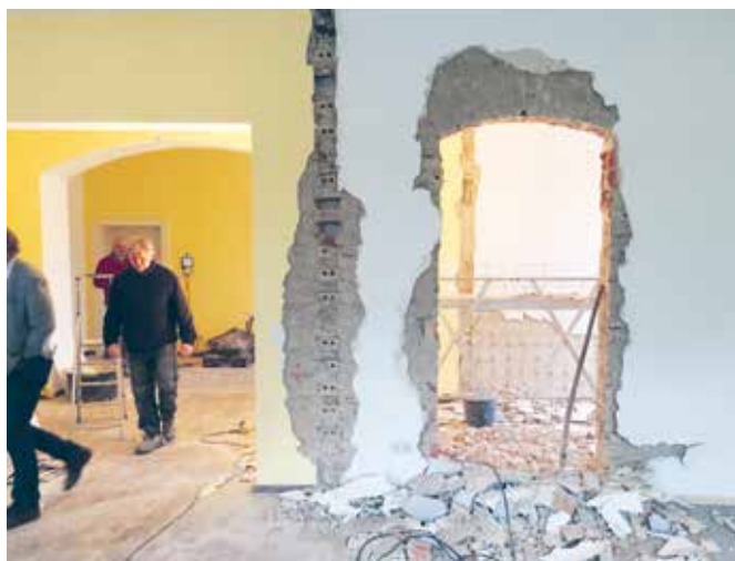
Bauliche Maßnahmen im Jacobson-Haus
